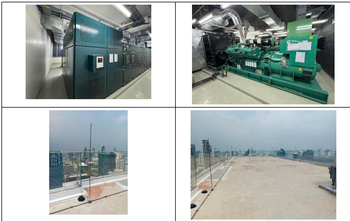
ภาพที่ 1.3.7-1 ระบบไฟฟ้าและระบบป้องกันฟ้าผ่า
